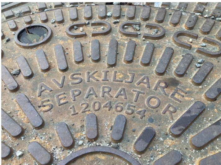
Fig. 7. Märkning av locket på en oljeavskiljare. Foto: Naturvårdsverket.
