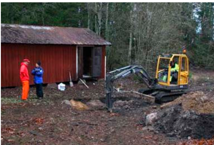
Figur 7. Grävning av IVL Tö 2. Notera den sparsamma växtligheten på ytan
