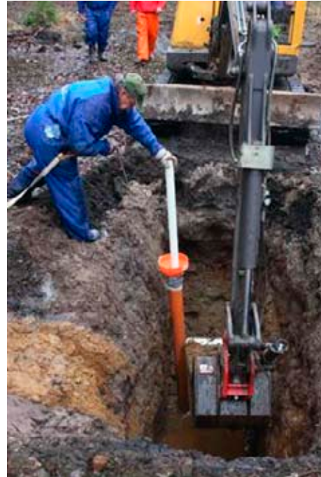
Figur 11. Installation av grundvattenrör IVL Tö 2
