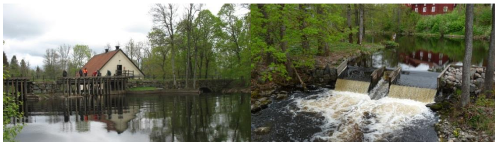
Figur 7. Dammen ovanför kvarnen. Till höger syns befintligt skibord med rester av fiskväg och stenalvsbron, till vänster syns dammluckorna.
