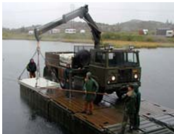
Bild 9. På bilden visas lyftenheten som användes vid försöket, ponton och lastbil. I kranen hänger en av 10 frysceller (ur Frysmuddring av sjön vid stationshuset i Vassijaure , se referenser, med tillstånd av Banverket Norra banregionen).
