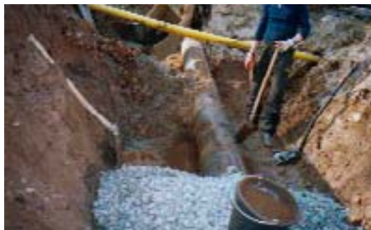
Bild 13-14: Utläggning av värmebehandlad torv invid kabeltrumma och överfyllning av makadam.
