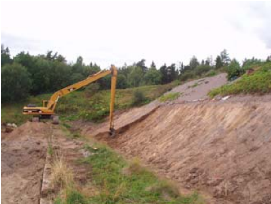
Figur 2-1: Skiktvis/pallvis schaktning av blyförorenad jord i skjutvall/kulfång. (Källa: Johan Helldén AB).
