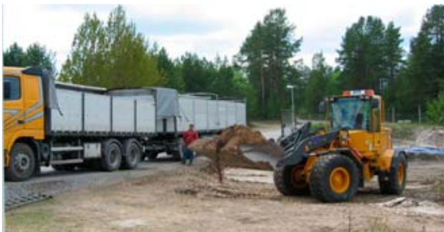
Figur 1-5. Bilden visar lastning av förorenade massor vid saneringen av Hanssons Såg i Luleå, 2003 (projekt 3, bilaga 1). (Foto: Thomas Liljedahl).
