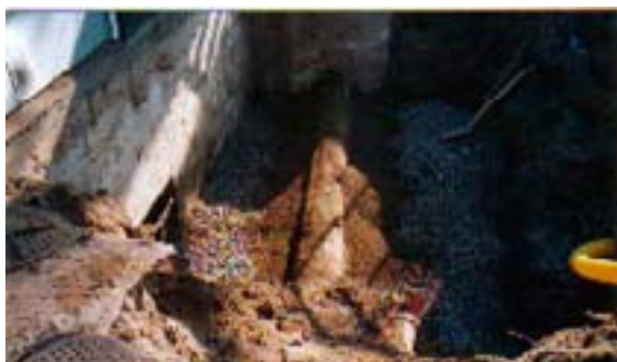
Bild 13-14: Utläggning av värmebehandlad torv invid kabeltrumma och överfyllning av makadam.
