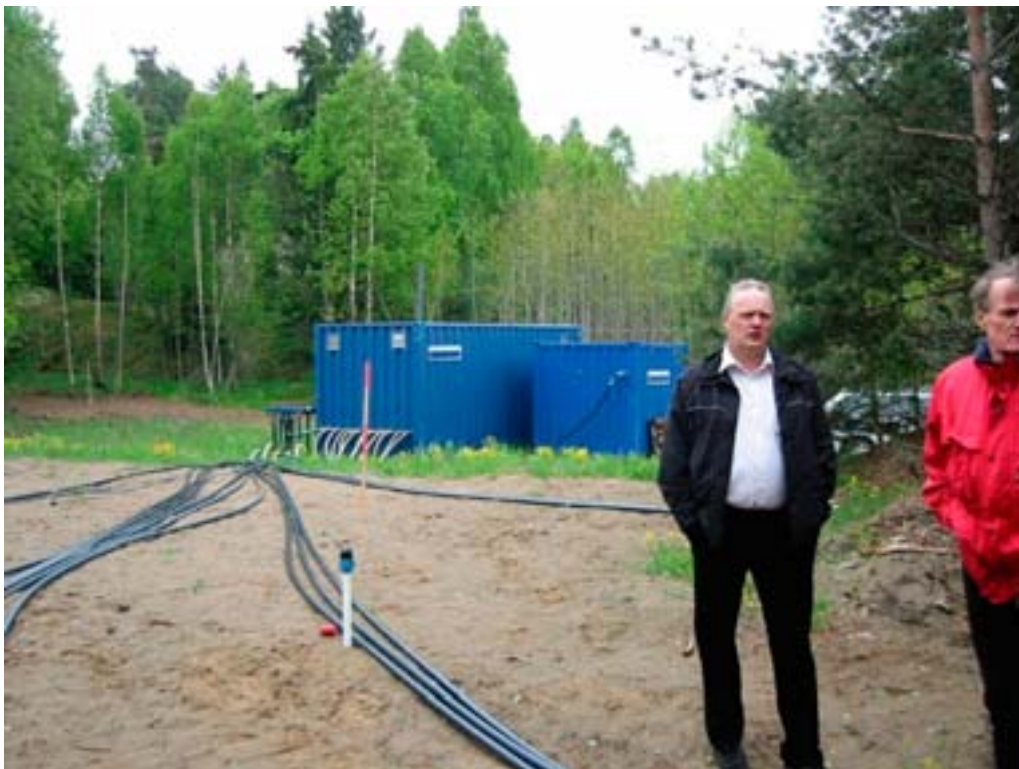
Figur 3-1: Exempel på anläggning för vakuumextraktion. Efterbehandling av markområde vid f d F18 Tullinge som har förorenats av flygdrivmedel (Källa: MB Envirotech AB och Johan Helldén AB)
