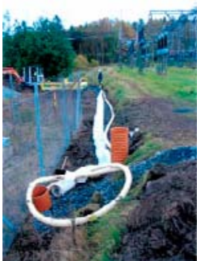
Bild 12. Arbete med invallning av det förorenade området vid transformatorstationen i Stenkullen, Lerum (Källa: Rolf Bergman, Vattenfall, Trollhättan).
