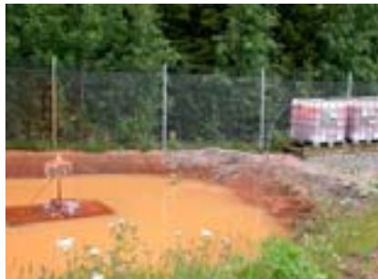
Bild 10. Bilden visar luftningsanläggning med cisterner och damm vid saneringen av Teknos i Tranemo (Bildkälla: Peter Nacke, Teknos Tranemo AB).
