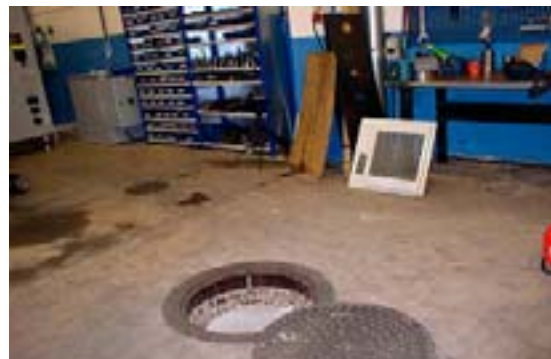
Figur 4-5. Bilderna visar från vänster till höger: Installation av brunn för injicering av kalkhaltigt vatten till marken, brunn A vid nya provtagningar hösten 2005 (Bildkälla: Sten Martinsson, Värnamo kommun).
