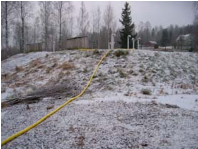
Figur 3-5: Exempel på markfilter med aktiv pumpning. Behandling av lakvatten från arsenikförorenat markområde vid Gunnita f d impregneringsplats, Kils kommun. (Källa: Johan Helldén AB)
