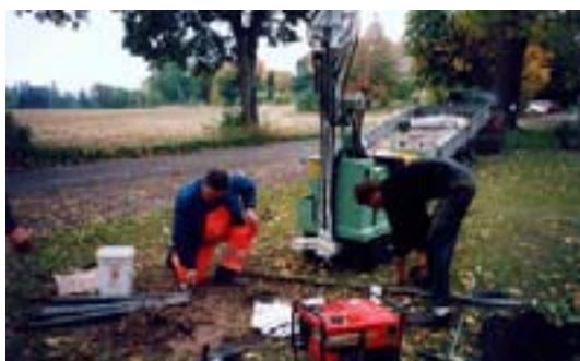
Figur 1-2. Bilderna visar från vänster till höger: Förberedelser för injicering och det förorenade området med nedsatta kontrollrör (ur: Saneringsrapport Odensvi Prästgård, Västervik, se referenser ).
