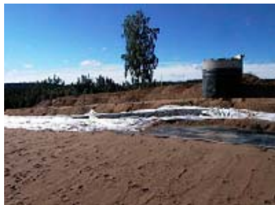
Figur 15-16. Övertäckning av den gamla syraslamgropen i Kniphammaren, Jönköping. Bilden till vänster visar anläggande av skyddslagret och bilden till höger visar terrasserings- och gasdräneringsbrunn (Källa: Mats Käll, Sweco, Jönköping).
