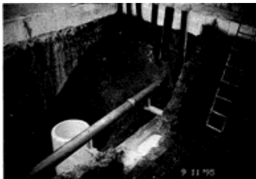
Figur 4-5. Bilderna visar från vänster till höger: Installation av brunn för injicering av kalkhaltigt vatten till marken, brunn A vid nya provtagningar hösten 2005 (Bildkälla: Sten Martinsson, Värnamo kommun).
