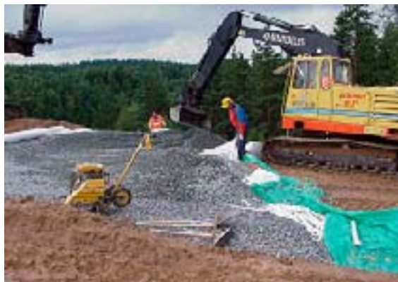
Figur 15-16. Övertäckning av den gamla syraslamgropen i Kniphammaren, Jönköping. Bilden till vänster visar anläggande av skyddslagret och bilden till höger visar terrasserings- och gasdräneringsbrunn (Källa: Mats Käll, Sweco, Jönköping).
