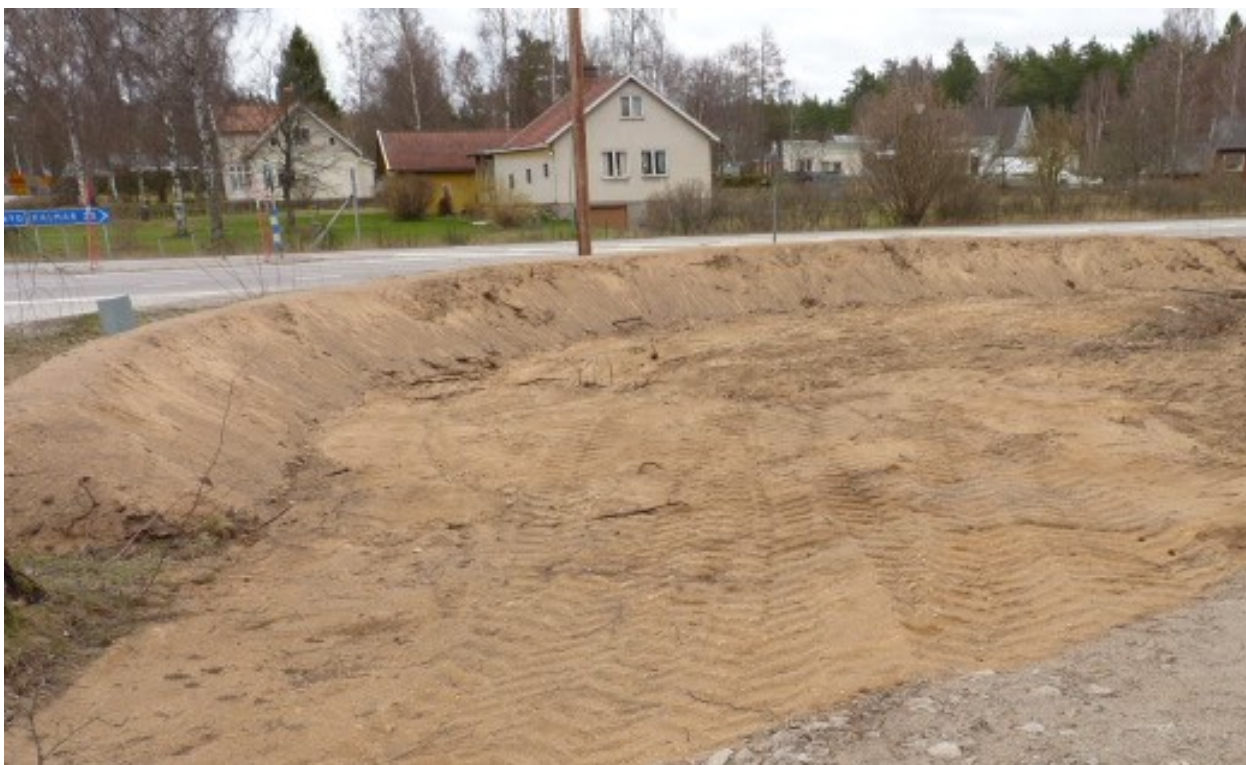
Bild 7. Helt nyanlagd, låg sandvall med en yta med blottad sand framför. Just denna struktur skapar värdefulla biologiska strukturer som på sikt gynnar en majoritet av de sandlevande insekter som finns vi Krukebo. Vallens, längd höjd och sträckning kan varieras. Vallarna kan till exempel fungera som ett bollhinder vid vägar eller avgränsning mellan olika banor. Ytan sås efter anläggning in med diverse ekologiska nyckelväxter som trivs på sandjordar och kommer efter hand övergå i en glest bevuxen, blommande ängsmark.
