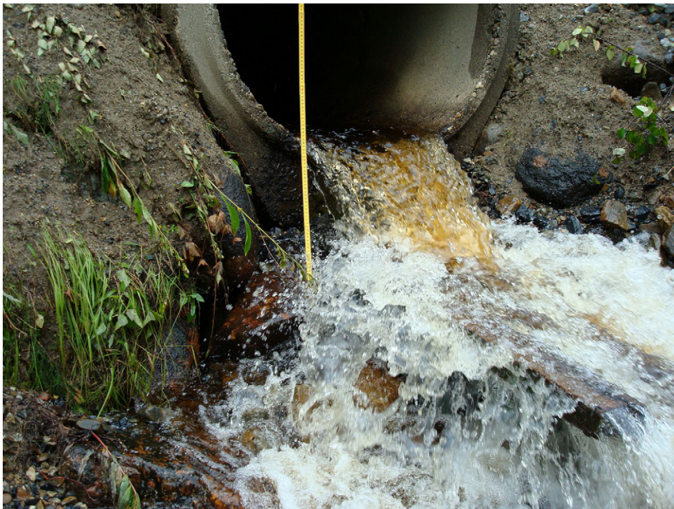
Exempel på vandringshinder för bäckröding. Kapaciteten för vägtrummor bör anpassas till vattenanläggningen. De bör inte begränsa flödet, men inte heller orsaka vandringshinder för fisk. Foto Nils-Erik Oderljung.
